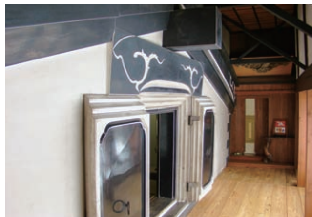
上屋（簷）に覆われた内蔵（母家蔵2階部分）。建物の中に蔵がある様子がよく分かる。（筆者撮影）
