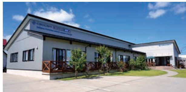
本社工屋 明るく開放的で緑が映える
