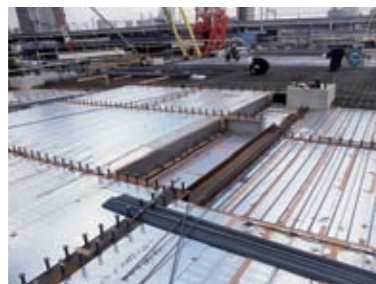
デッキプレートを用いた作業風景
